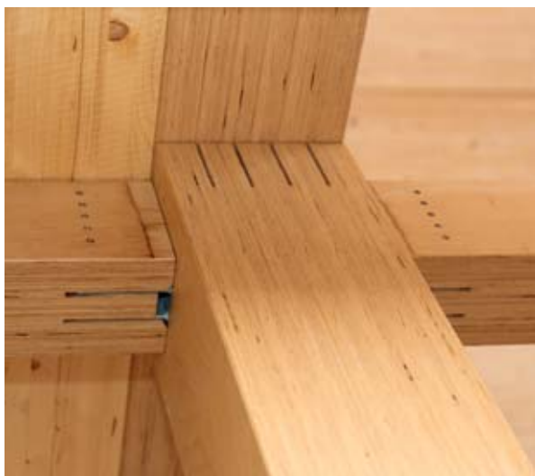
Im konstruktiven Bereich ist Baubuche das bisherige Flaggschiff unter den Laubhölzern. BauBuche ist ein Furnierschichtholz aus Buchenholz und liefert im Vergleich zum Nadelholz deutliche höhere Festigkeiten und damit eine sehr hohe Tragfähigkeit. Die Bilder entstammen einem Bauprojekt „Logistikzentrum mit Verwaltungstrakt“ der Holzbau Amann GmbH für die Chemofarm AG, Wendlingen. © Martin Granacher
